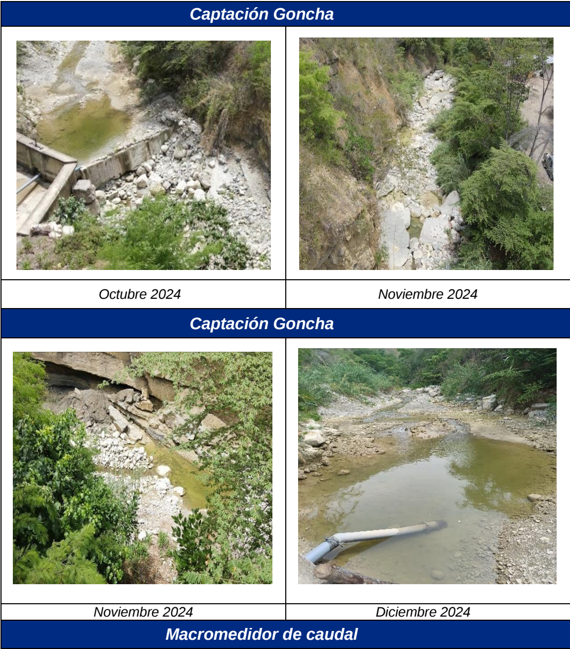
Figura N° 1. Captación de Goncha, con bajo caudal debido a inicio de estiaje, noviembre del 2024.
